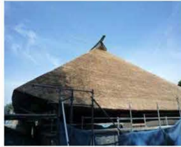
▲補修された本堂茅葺屋根
